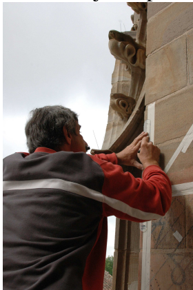
Mise en place des repères nécessaire à la pose des styles
