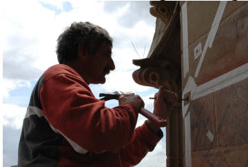
Débouchage des trous d'ancrage à l'aiguille de sculpteur. Le moindre coup de travers, et la pierre d'angle éclate.
