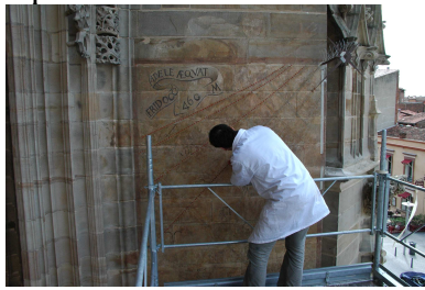
Mise en place du tracé
