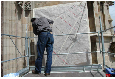
Mise en position du calque
