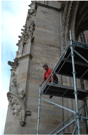
Pose de la tour roulante,
