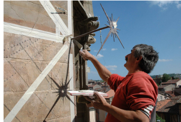
Scellement des styles à la chaux et au sable. Première ombre, attention ! Ne pas se fier au tracé qui est faux.
